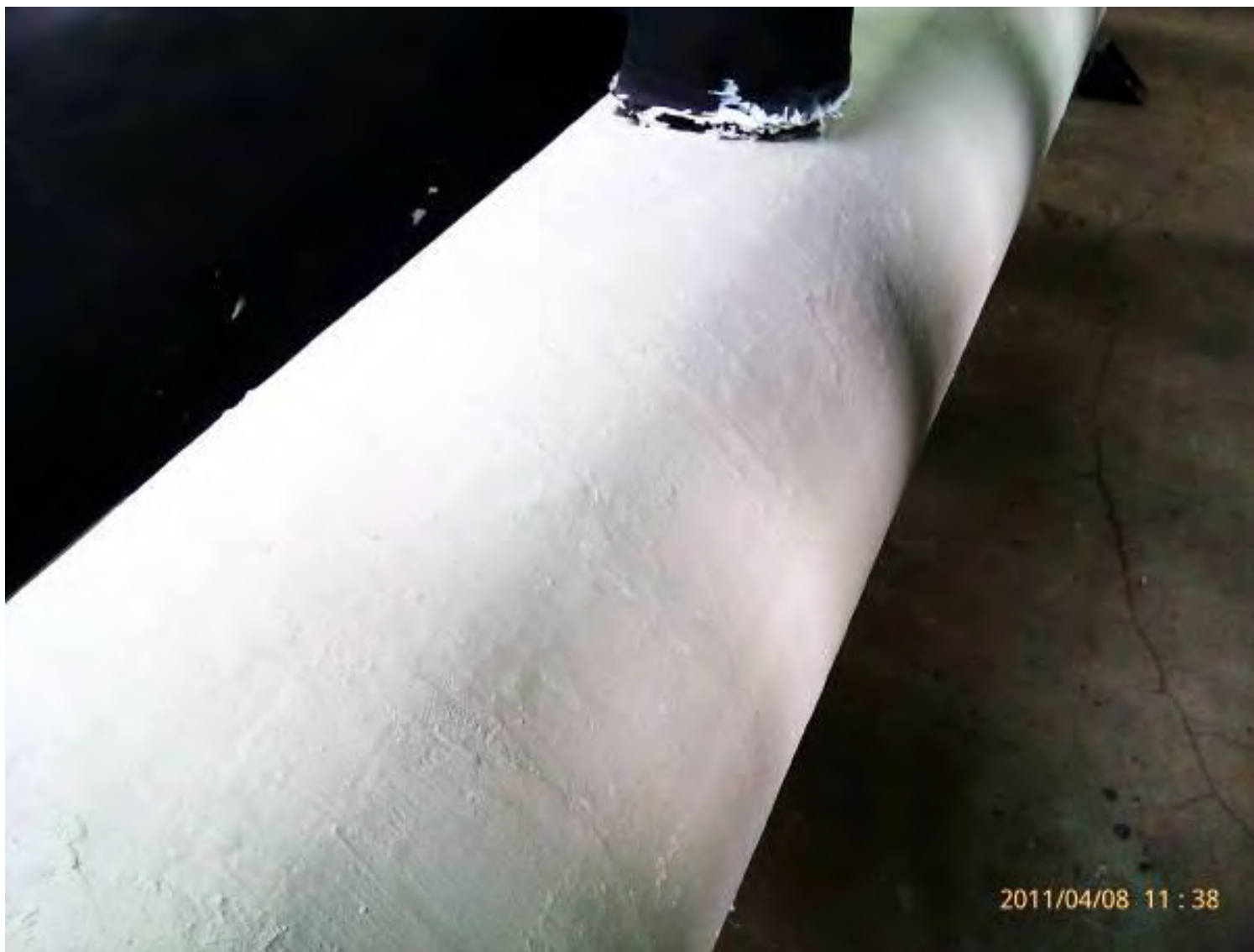
ГВС , котельная, г.САНКТ-ПЕТЕРБУРГ, 2011г.
