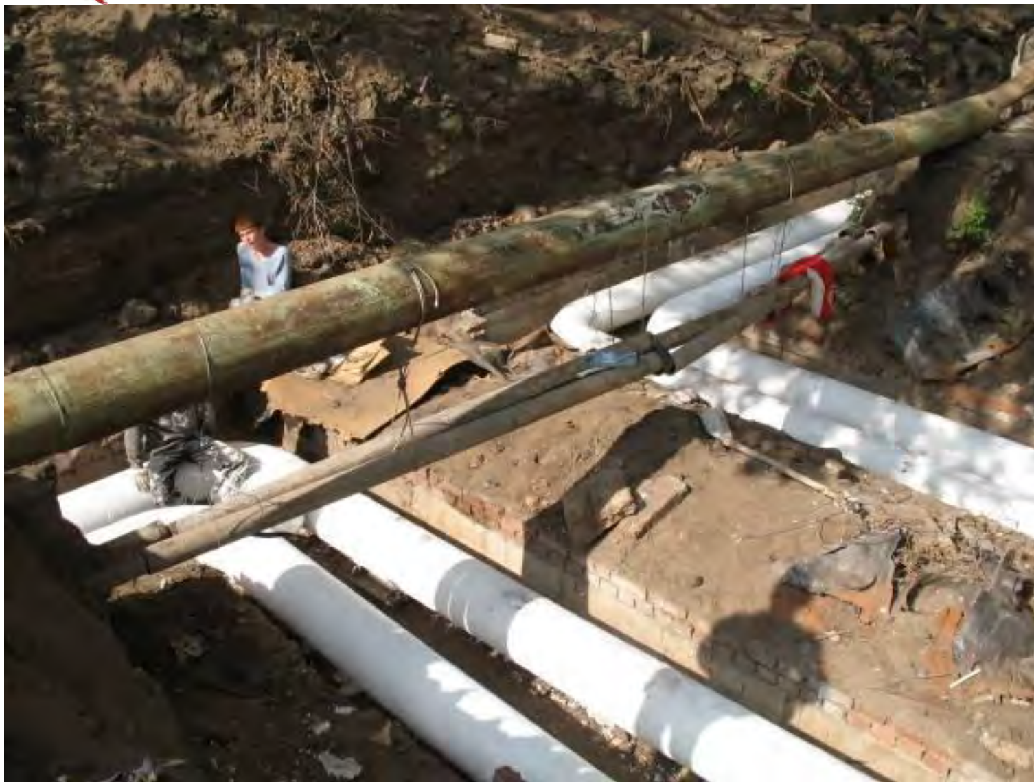
ТЕПЛОТРАССА, г.ВОРОНЕЖ, 2010г.
