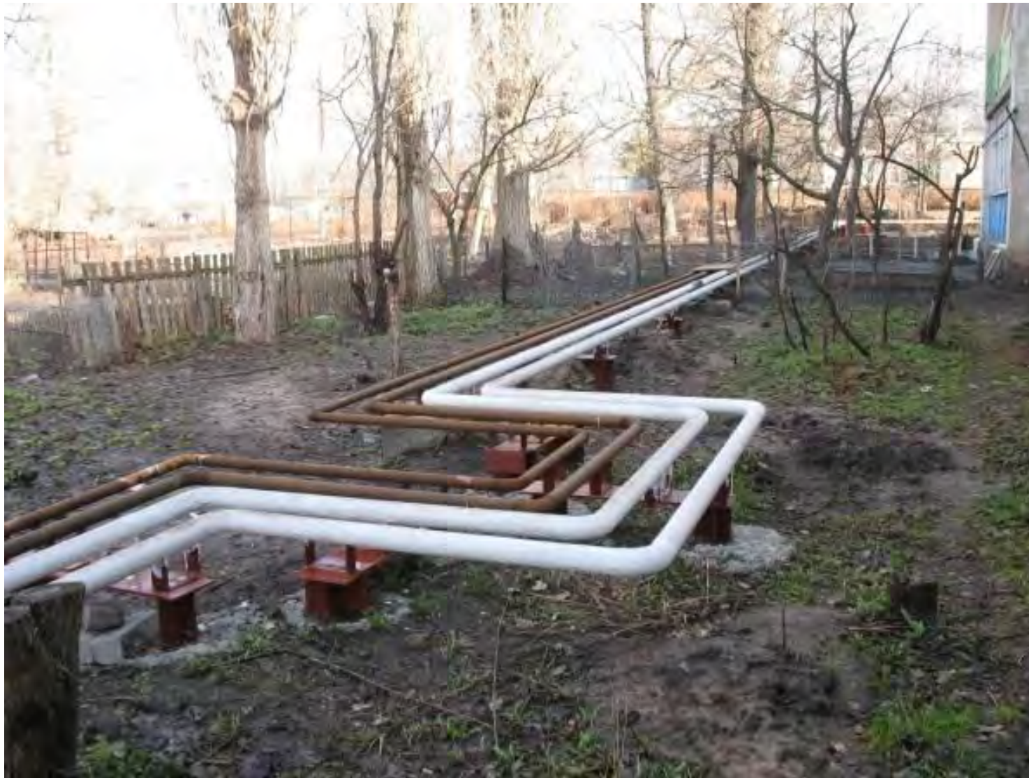
ТРУБОПРОВОД ДЕТ. САДА, п.СОМОВО, 2011г.
