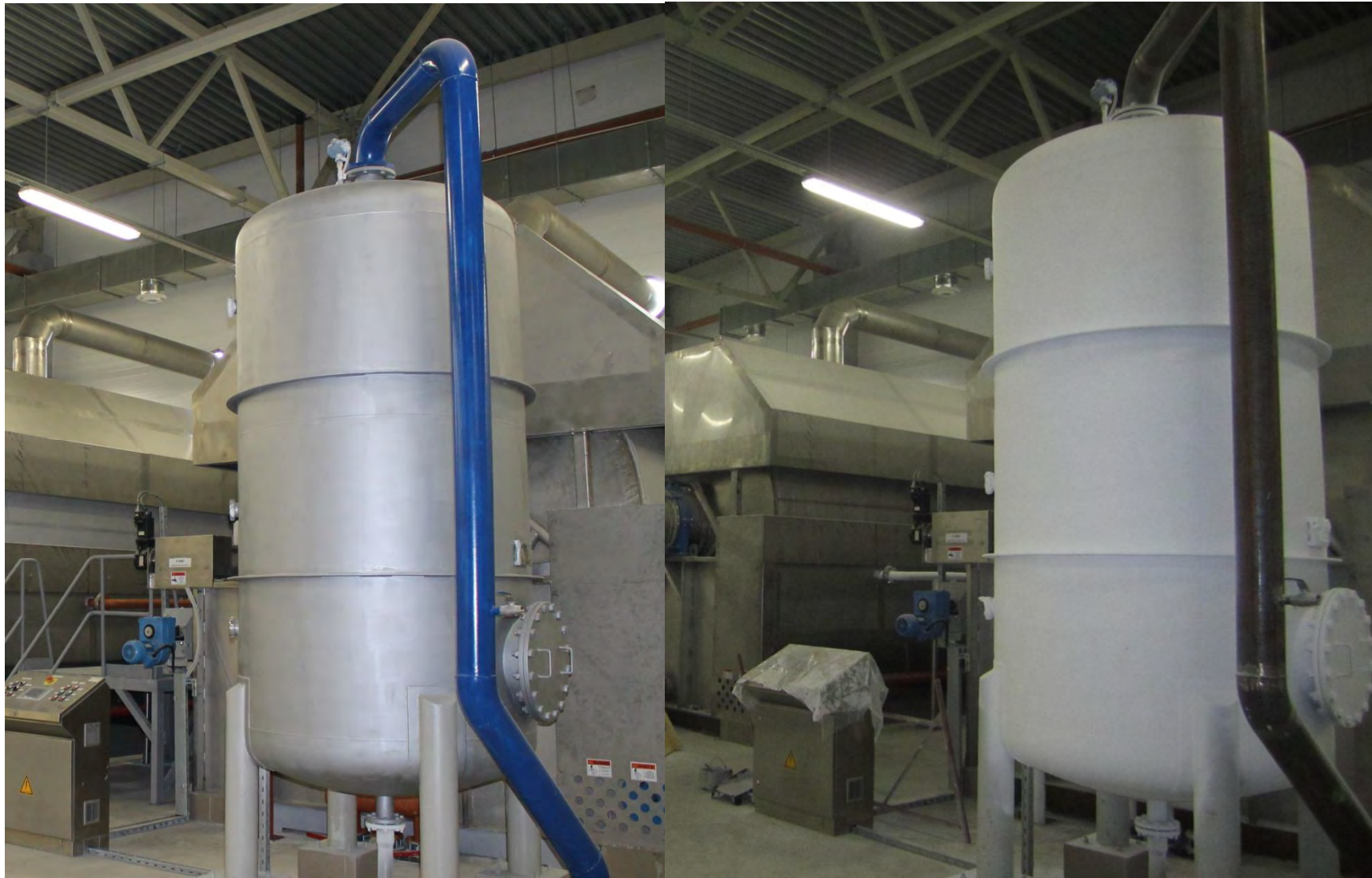
КРАХМАЛЬНЫЙ ЗАВОД, п. ШИЛОВО, 2011г.
