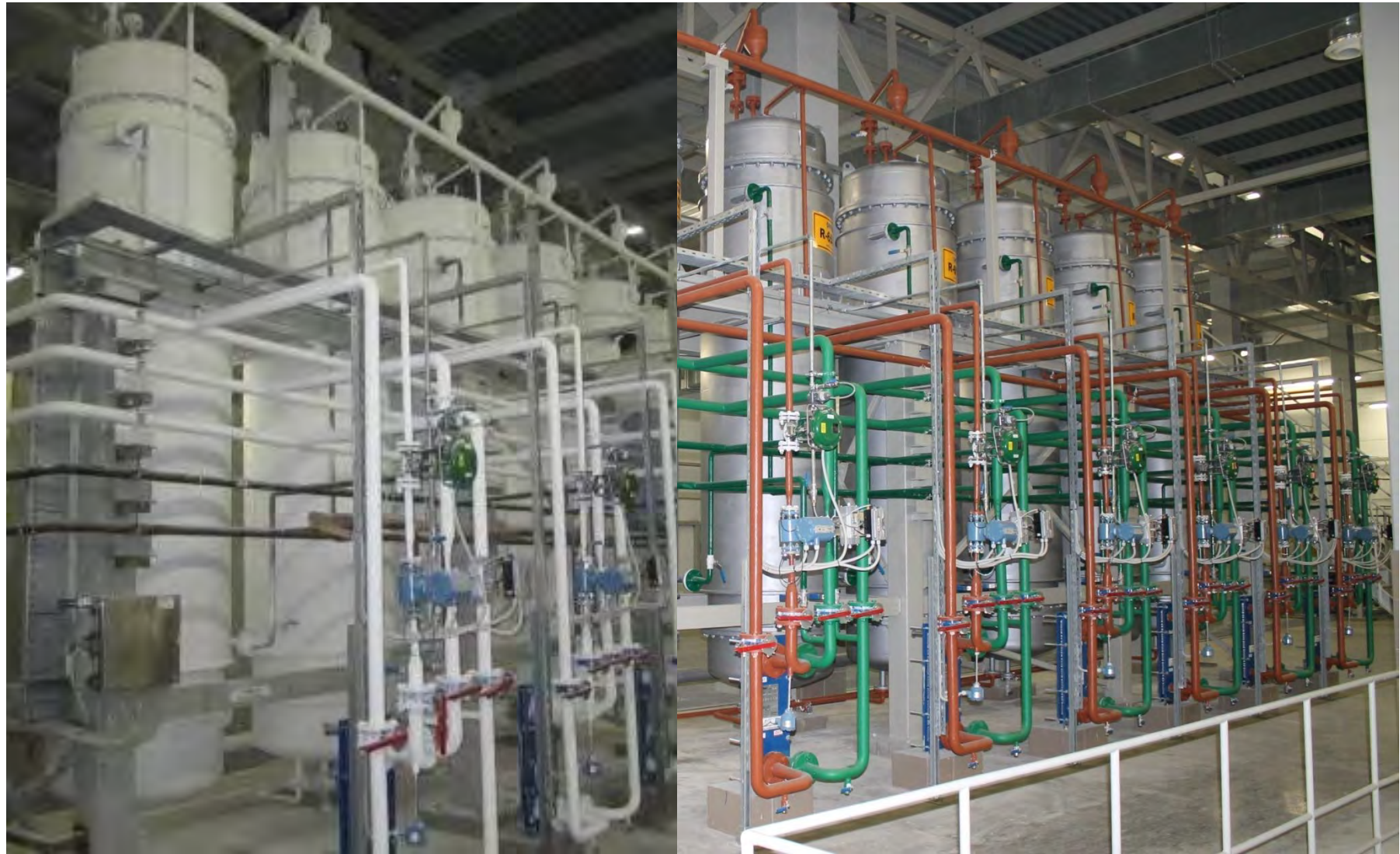
КРАХМАЛЬНЫЙ ЗАВОД, п. ШИЛОВО, 2011г.
