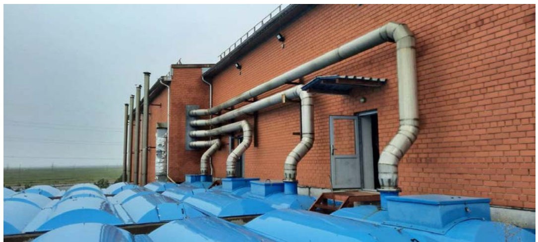
Фото 15 - Система газоочистки от песколовок
