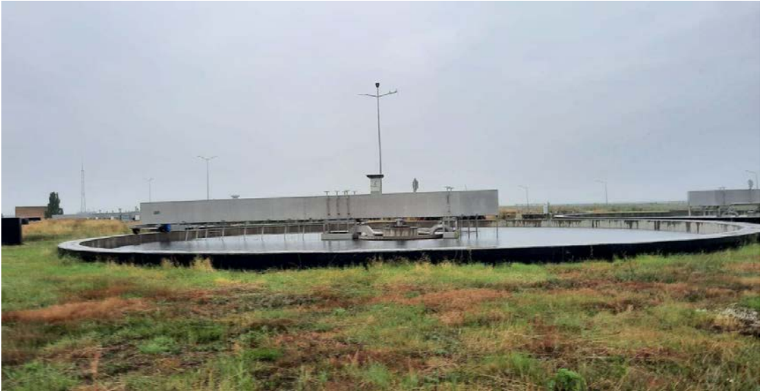
Фото 24 - Вторичный отстойник
