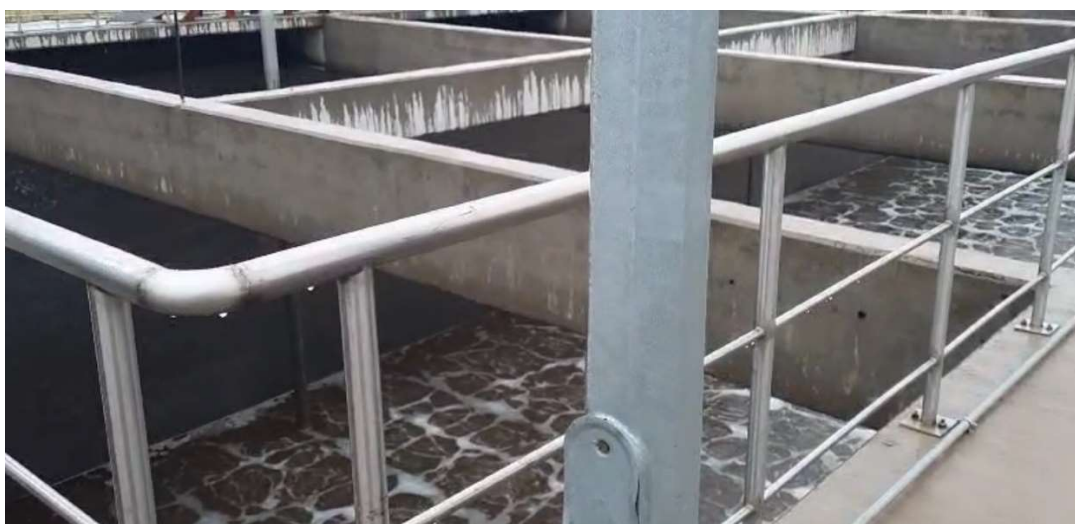
Фото 22 - Аэротенк 1 очереди на промывке
