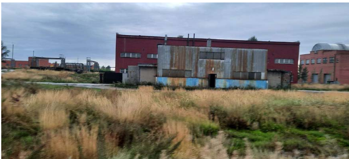
Фото 33 - Старый цех обезвоживания осадка
