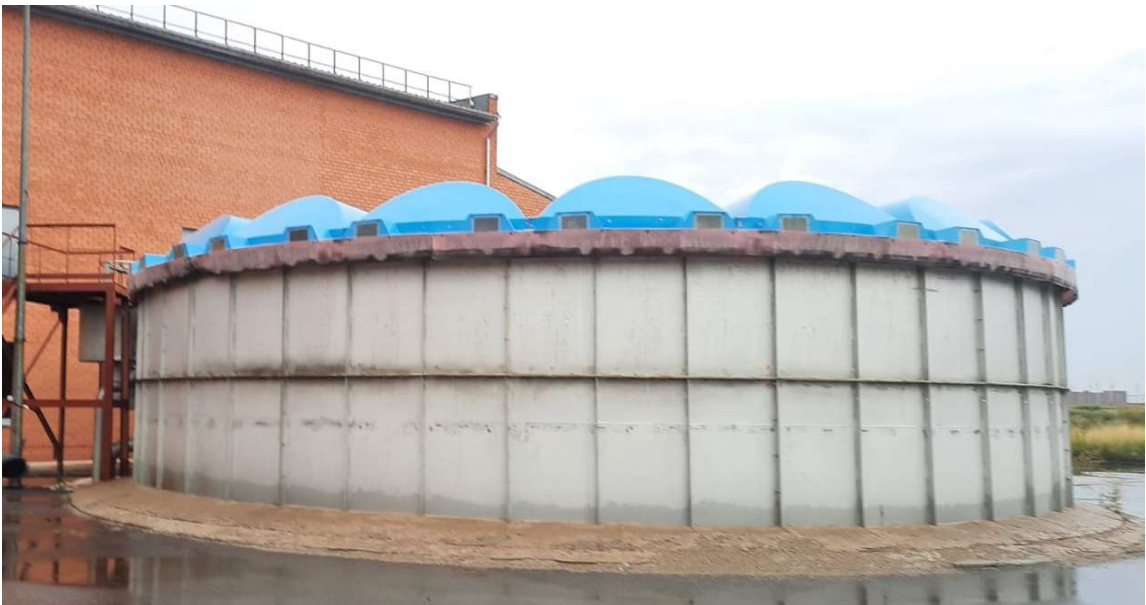
Фото 32 - Блок сгущения избыточного ила
