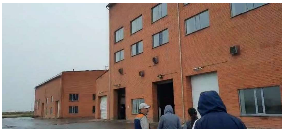
Фото 5 - Цех мехобезвоживания осадка 2 очереди
