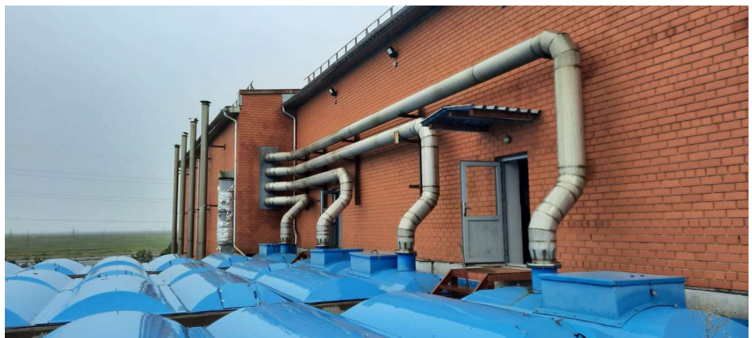
Фото 15 - Система газоочистки от песколовок
