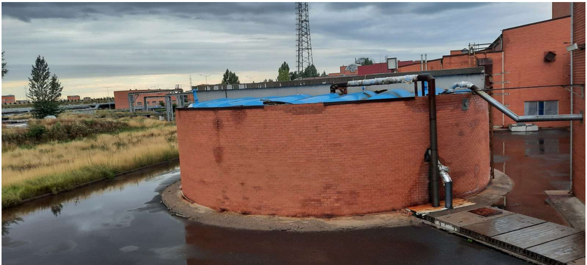
Фото 31 - Блок уплотнения сырого осадка
