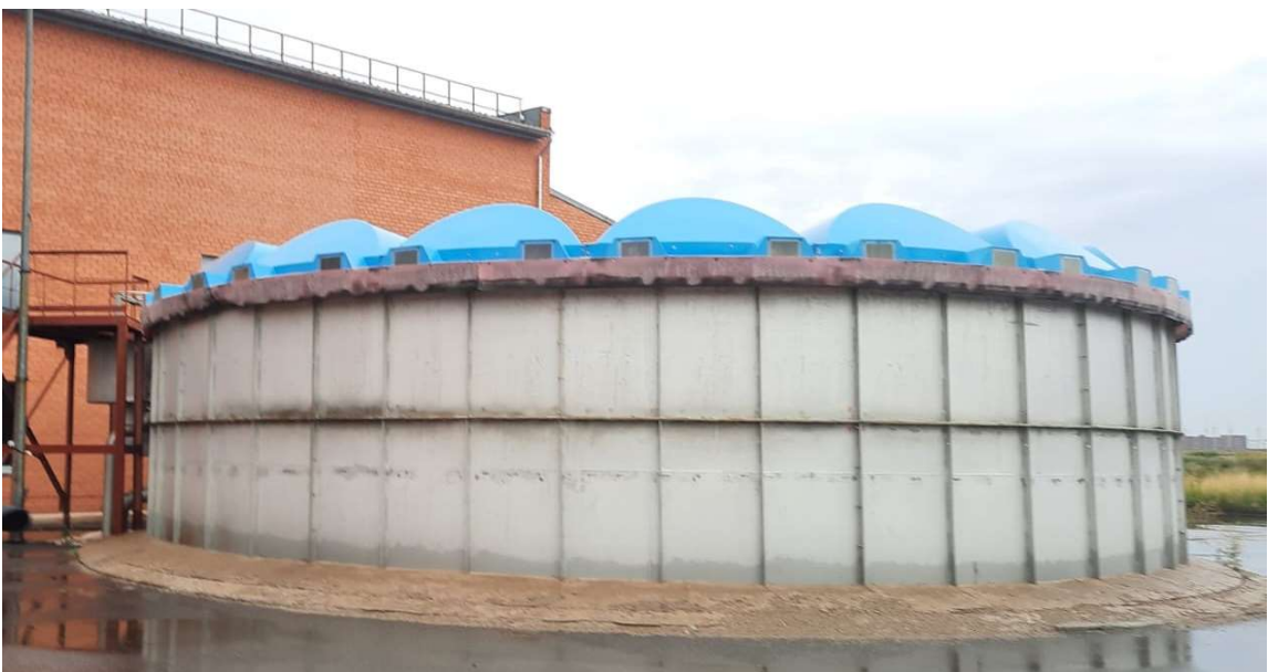
Фото 32 - Блок сгущения избыточного ила
