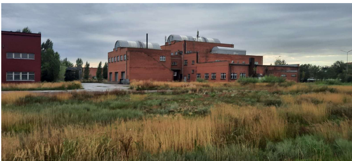
Фото 35 - Старый цех уплотнения осадка
