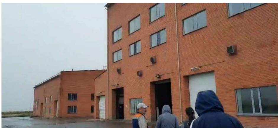
Фото 5 - Цех мехобезвоживания осадка 2 очереди
