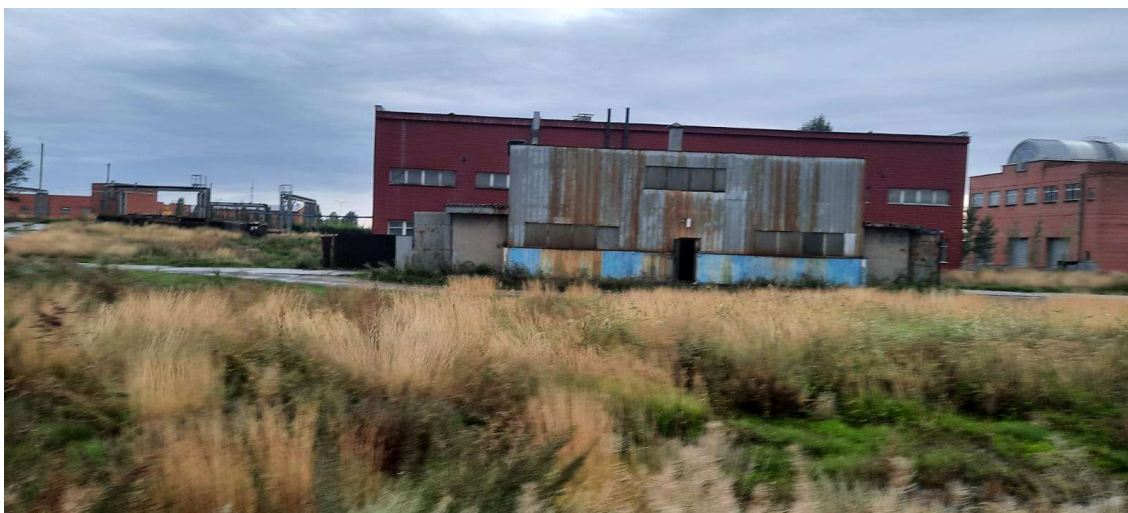
Фото 33 - Старый цех обезвоживания осадка
