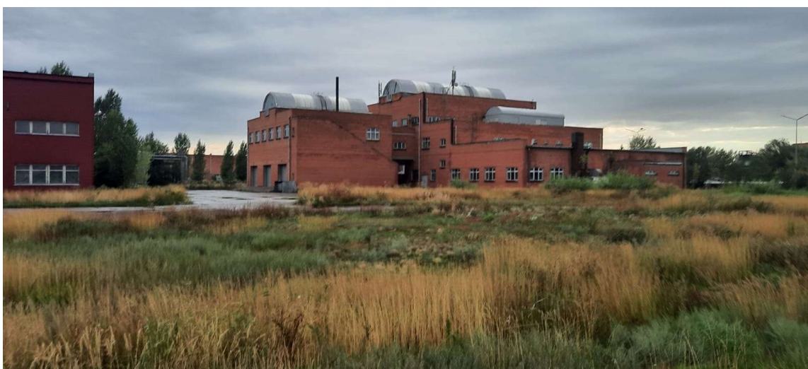
Фото 35 - Старый цех уплотнения осадка
