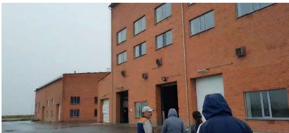
Фото 5 - Цех мехобезвоживания осадка 2 очереди
