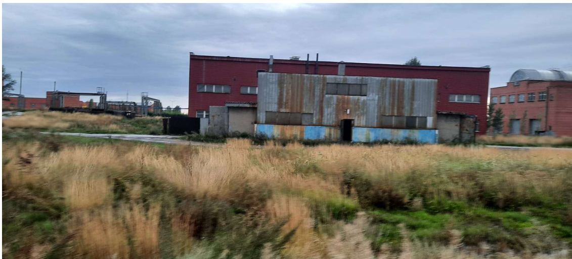
Фото 33 - Старый цех обезвоживания осадка
