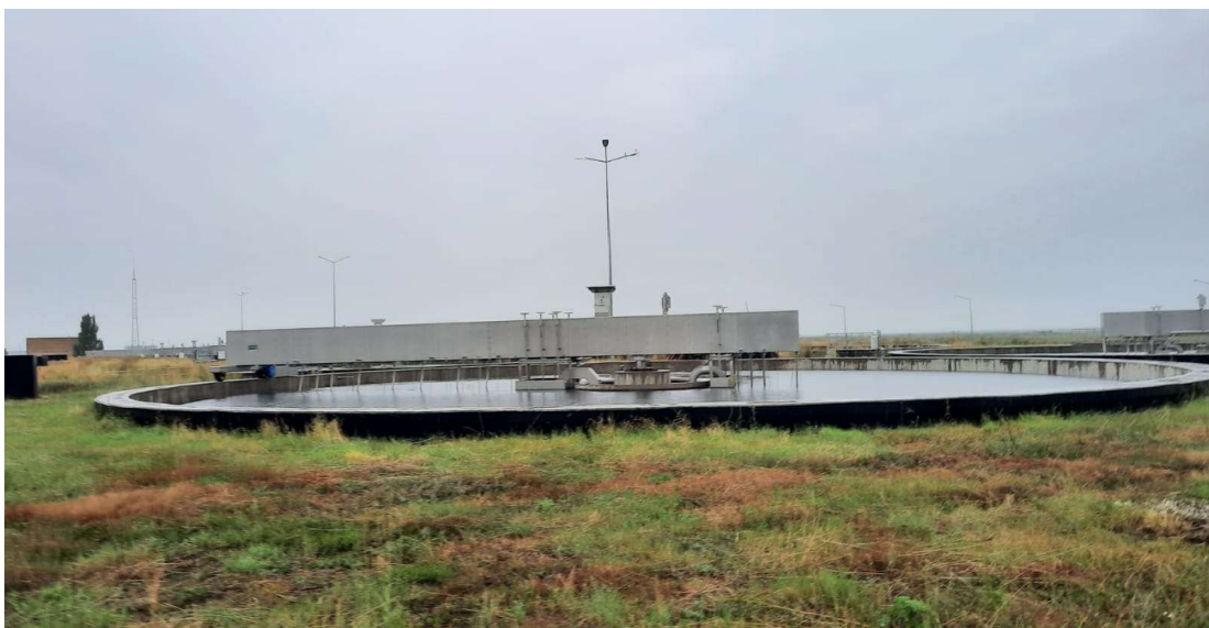
Фото 24 - Вторичный отстойник
