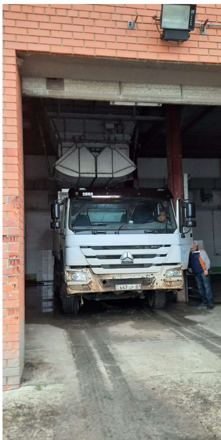
Фото 9 - Автомашина под загрузку обезвоженным осадком
